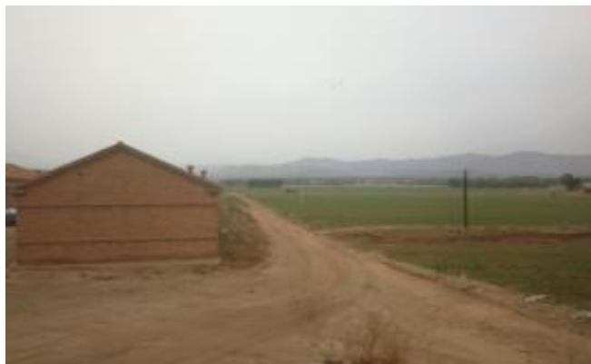
照片 4-5 矿区道路
