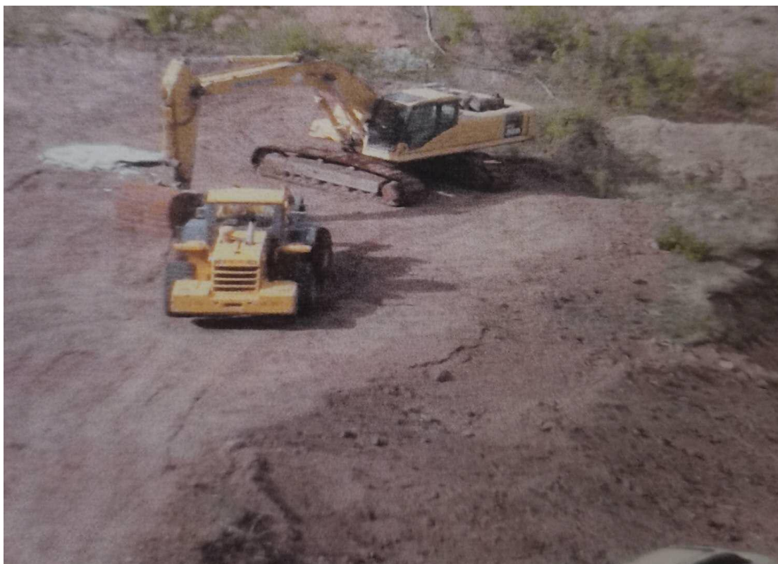
照片 4-3 表土存放场
