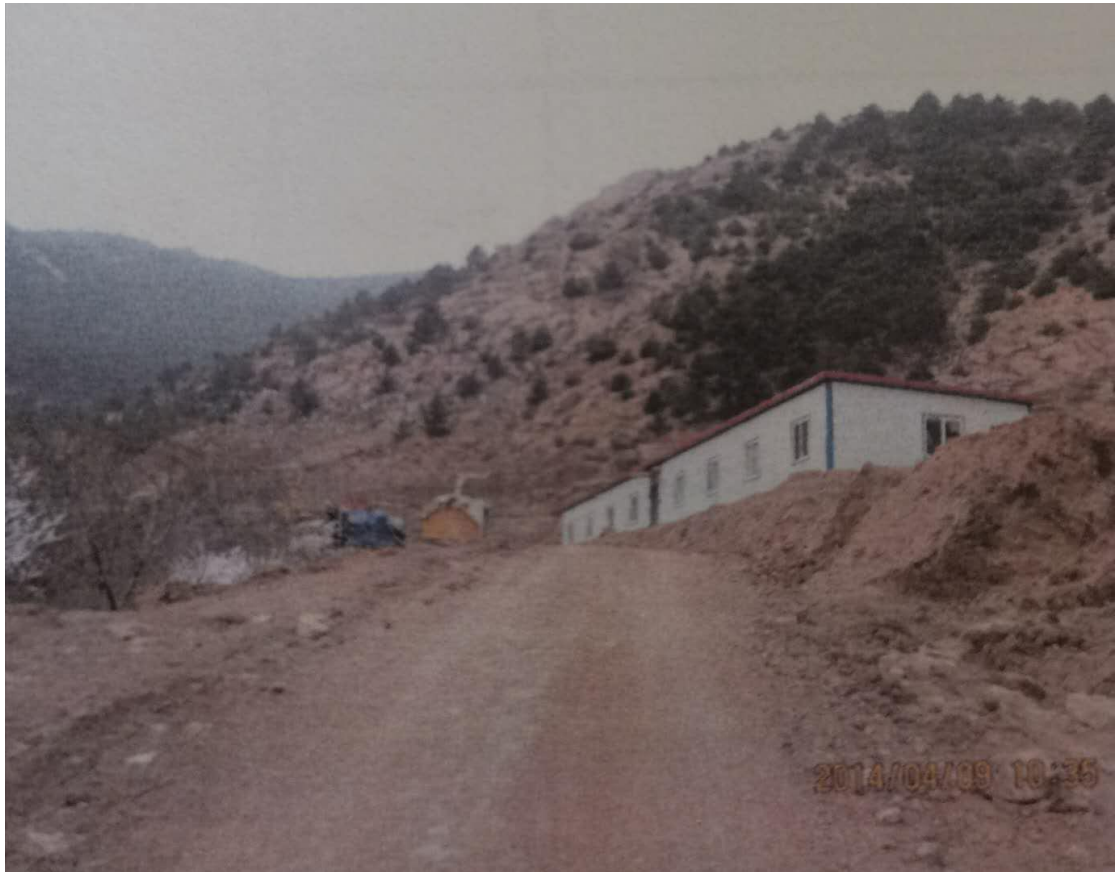
照片 4-5 矿区道路
